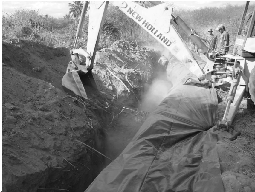
Fig. 4 Etapa final da construção da barragem subterrânea
