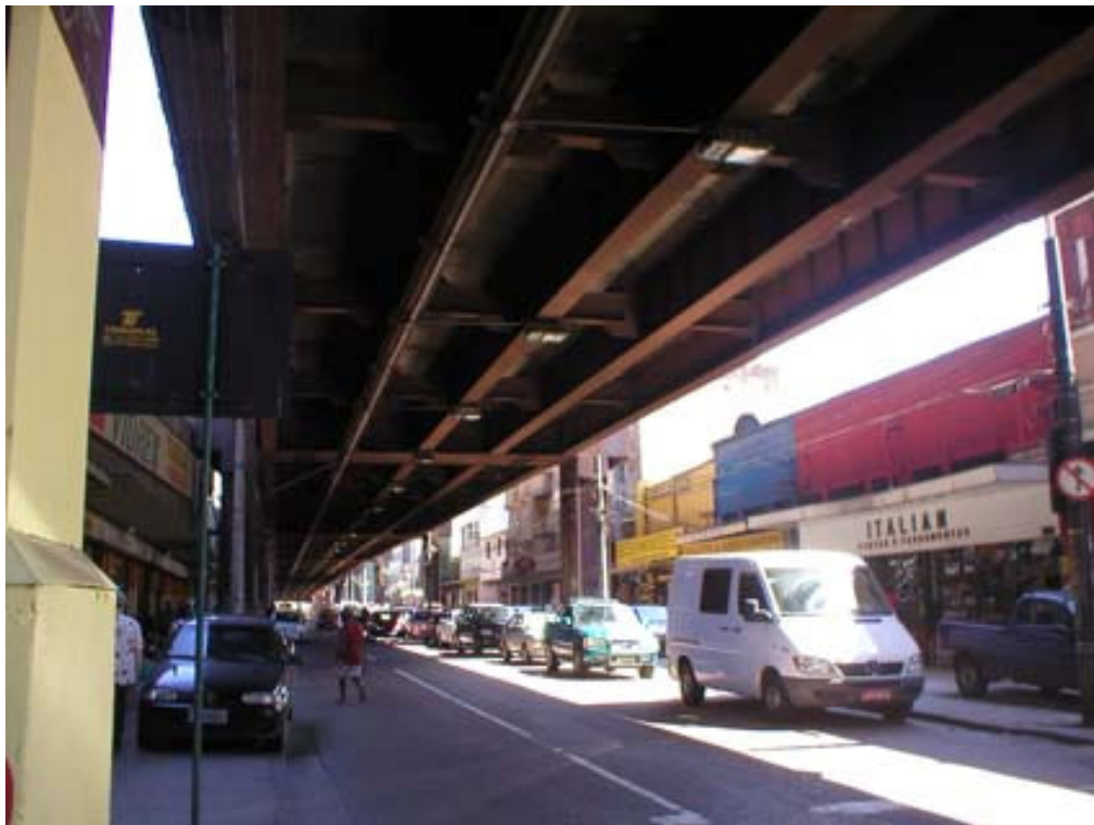
Fig. 9: Viaduto da Linha Vermelha sobre a Rua Figueira de Melo
