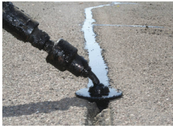
Fig. 3.1 Selagem de fendas
