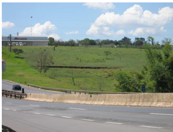
Figura 6: Área rural da Bacia do Córrego do Gregório, com detalhe para uma feição erosiva ao lado da rodovia Washington Luis. (05/01/2010)
