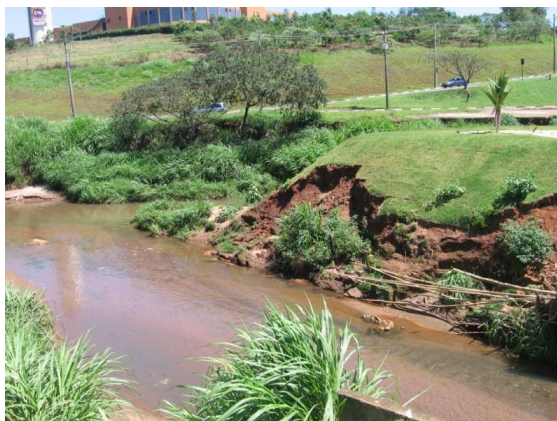
Figura 5: Foz do Córrego do Gregório no Córrego do Monjolinho, desbarrancamento das margens. (15/12/2009)
