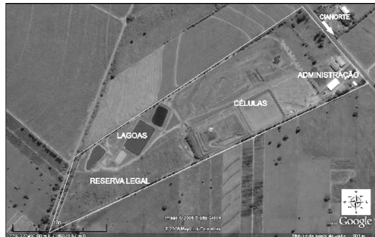
Fig. 4 Vista aérea do Aterro Sanitário de Cianorte/PR. Adaptado de Google Earth (2010)
