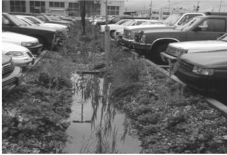
**Fig.09 Valas de Infiltração.**
