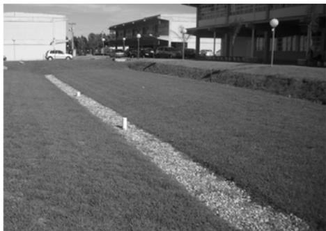
**Fig.11 Trincheira de Infiltração.**
