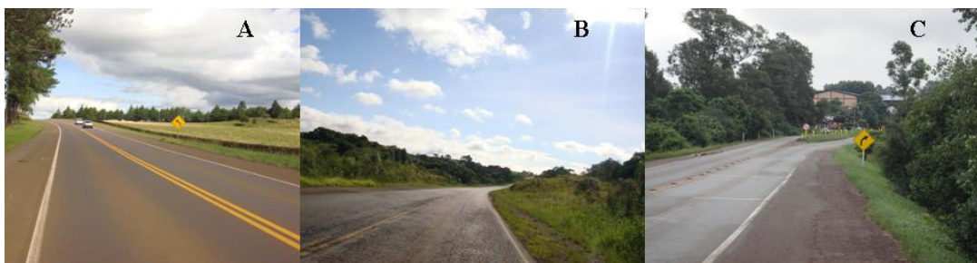
Fig. 7 Problemas na infra-estrutura da rodovia
