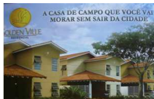
Fig. 2 e 3 Condomínio Vilagaia e Residencial Golden Ville
