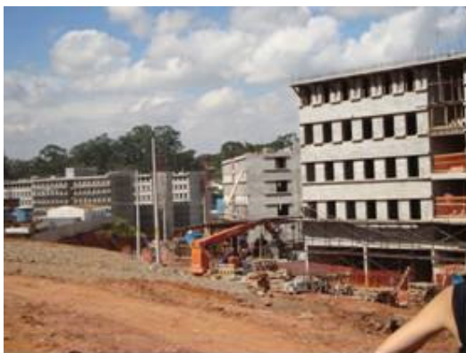
Vista dos edifícios que substituem as moradias precárias em áreas de risco, com alto coeficiente de aproveitamento e baixa taxa de ocupação.
