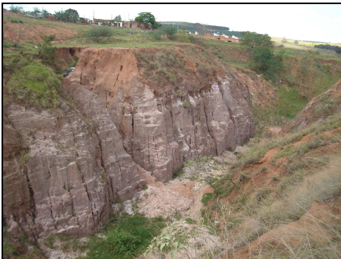
Fig. 03 – Talude erosivo com aproximadamente 25 metros de altura;
