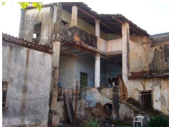
Fig. 4 Vista interna da edificação
