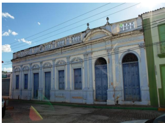
Fig. 1 Fachada da Rua 7 de Setembro
