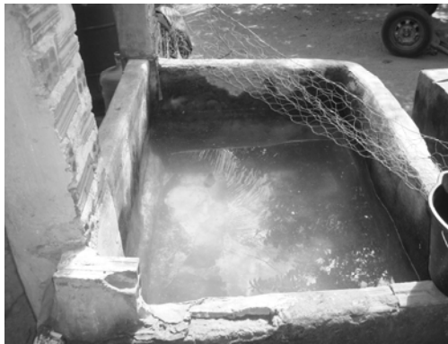
Figura 3 – Armazenamento inadequado da água
