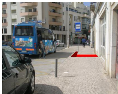
Figura 7 Piso táctil em paragens de autocarro (Fonte: Saraiva et al. , 2008)
