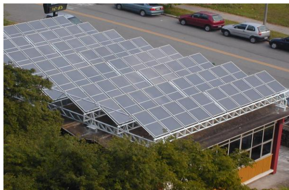
Fig. 5 Aquecedor solar do restaurante central (RU-CRUSP)
